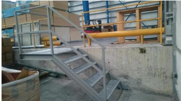
Escalera acceso choferes
